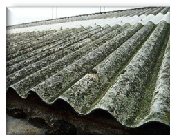
Toitures en plaques ondulées
